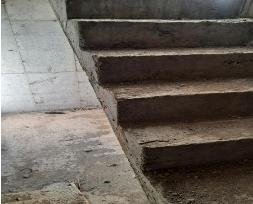
▲ 계단 안전난간대 누락
