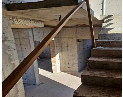
▲ 점검 종료 후 안전난간대 설치
