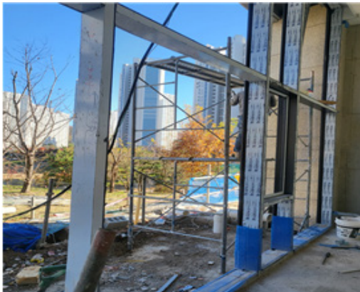
▲ 이동식 틀비계상부 안전난간대 일부 미설치
