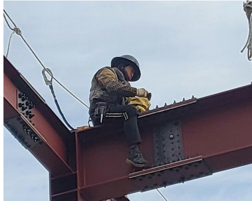
▲ 철공위 작업중 안전걸이 설치조치
