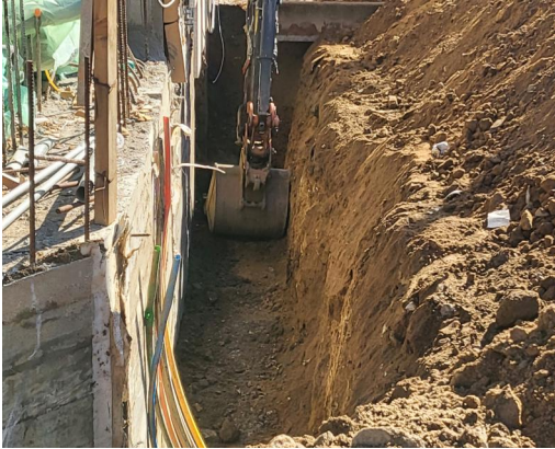
▲ 토공 터파기시면 기울기 설계기준 미준수
