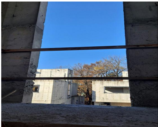
▲ 점검종료 후 안전난간대 설치
