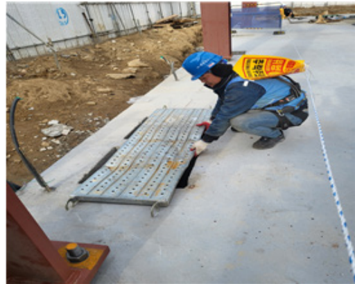
▲ 개구부 안전덮개 설치조치
