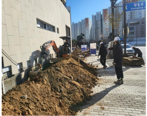
▲ 토공 터파기시면 기울기 설계 준수하여 토사 붕괴 방지 권고
