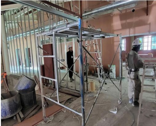
▲ 이동식 틀비계상부 안전난간대 미설치
