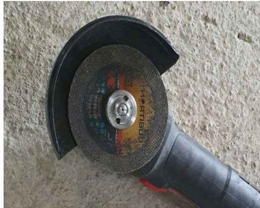
▲ 위험요인 설명 후 커버 설치
