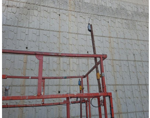
▲ 위험요인 설명 후 센서 설치
