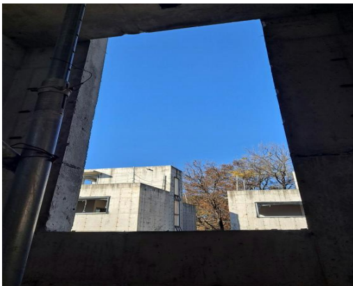
▲ 계단창측 개구부 안전난간대 조치요망
