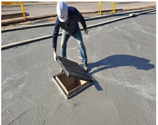
▲ 점검 지적 후 즉시 덮개 설치
